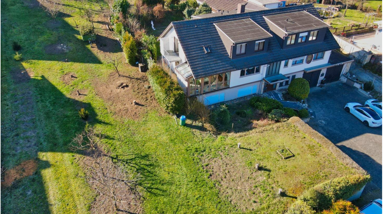
Abb. 6: Luftbild der zu bebauenden Grundstücke
