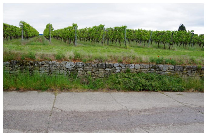
Abb. 7: Nördlich angrenzende Bruchsteinmauer
