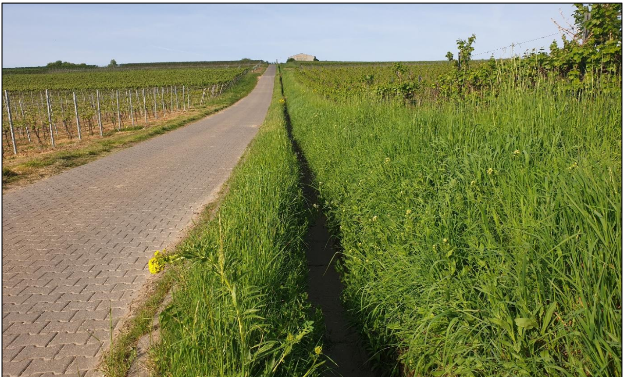
Abb. 21: Teilverbauter Graben im Norden
