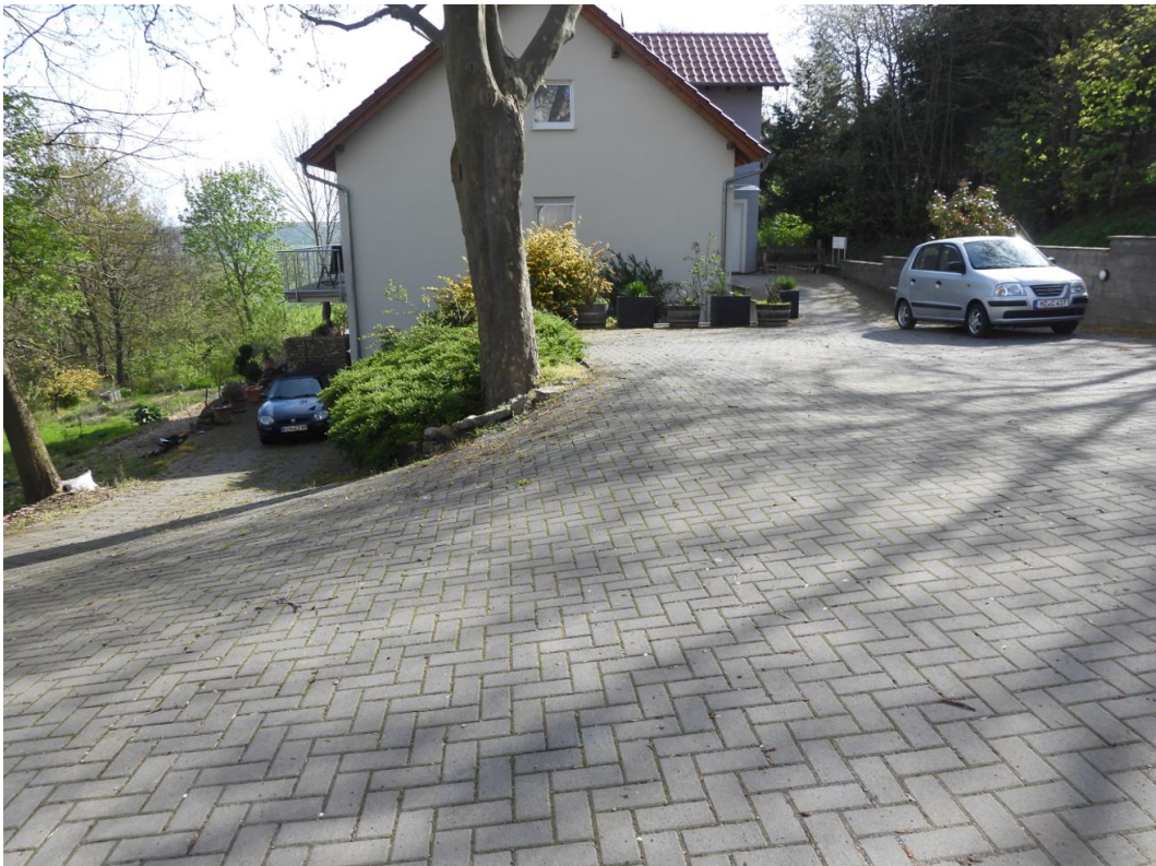
Bild 02: Weiterer Blick auf das Wohngebäude in Teilgeltungsbereich A
