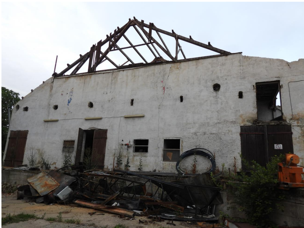
Bild 16: Ostansicht der Scheune
