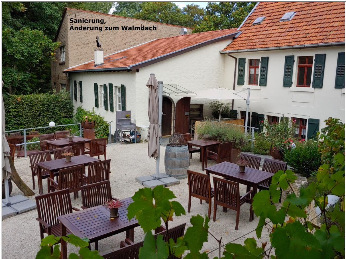
Fotostandort 6: Außenbereich mit Blick auf die zu ändernde Dachkonstruktion (siehe auch Foto 5)
