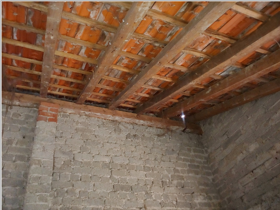
Fotostandort 5: Sanierung und Änderung der Dachkonstruktion in ein Walmdach
