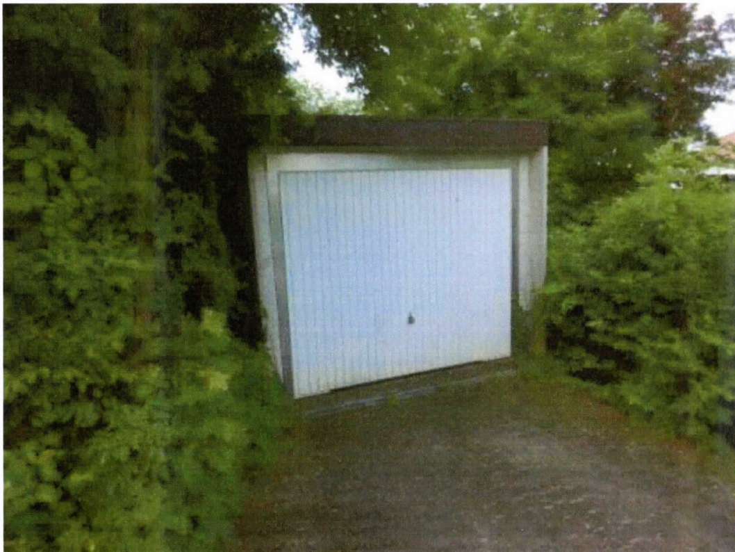
Bild 05: Garage im nördlichen Teil des Plangebietes
