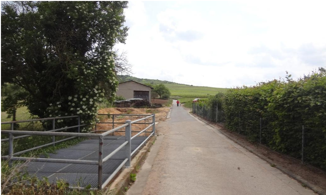
Abbildung 15: Schlammfang / Betonrinne am Ende der Michelstraße
