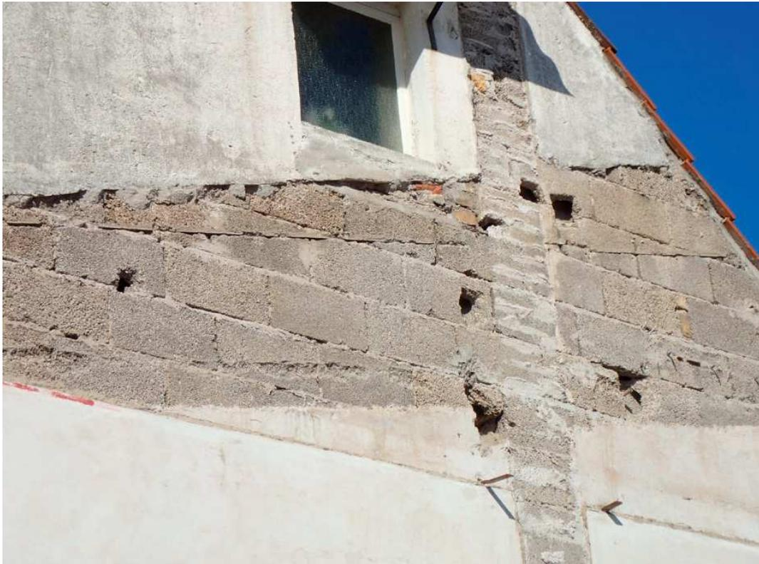
Bild 05: Blick auf die zu höhlenreichen zu sanierenden Mauerbereiche mit potentieller Habitateignung für Fledermäuse
