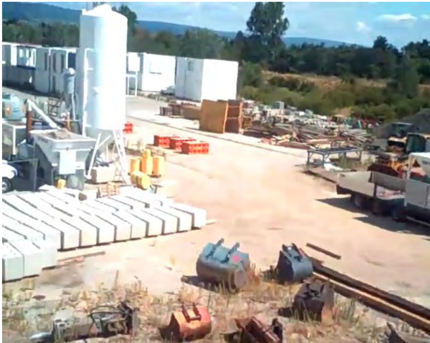
Bild 3: Lagerplatz für Bauzubehör
