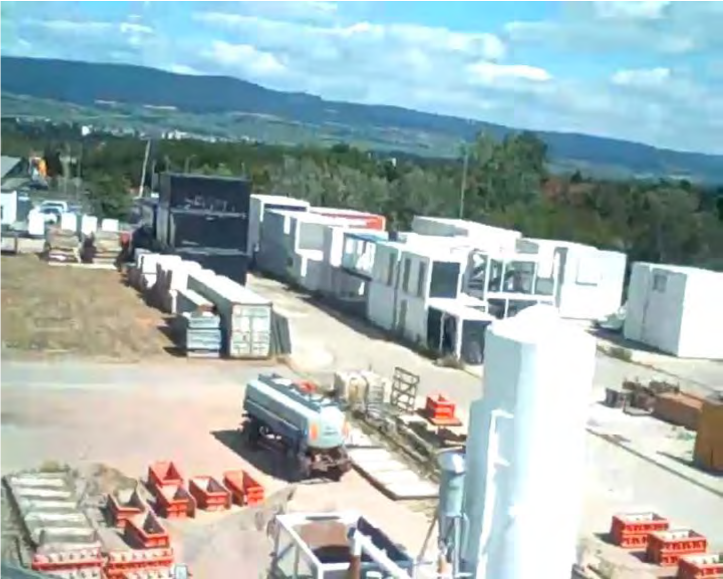
Bild 5: Lagerplatz für Bauzubehör
