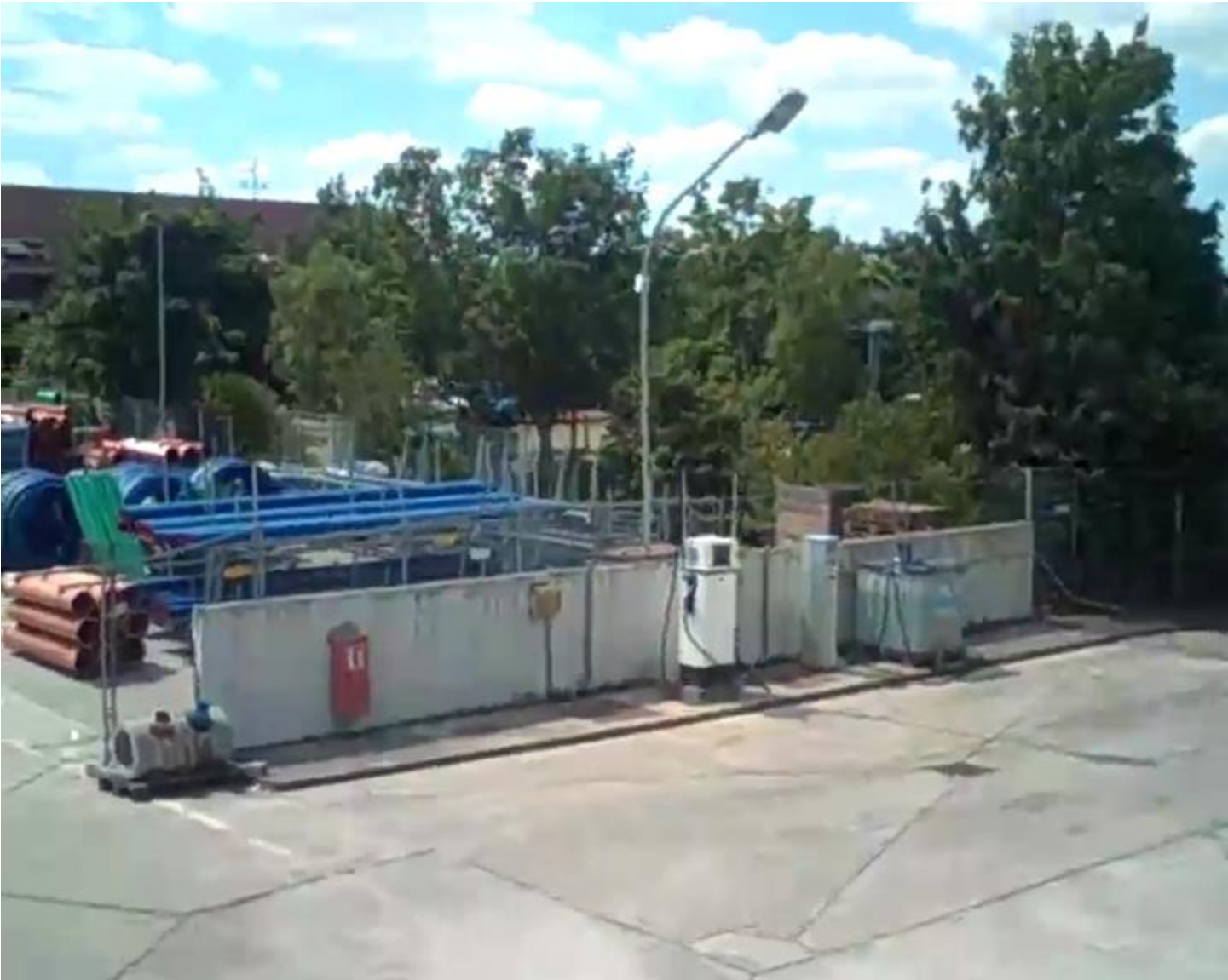
Bild 2: Betriebstankstelle im Bereich des westlich gelegenen Zufahrtsbereiches
