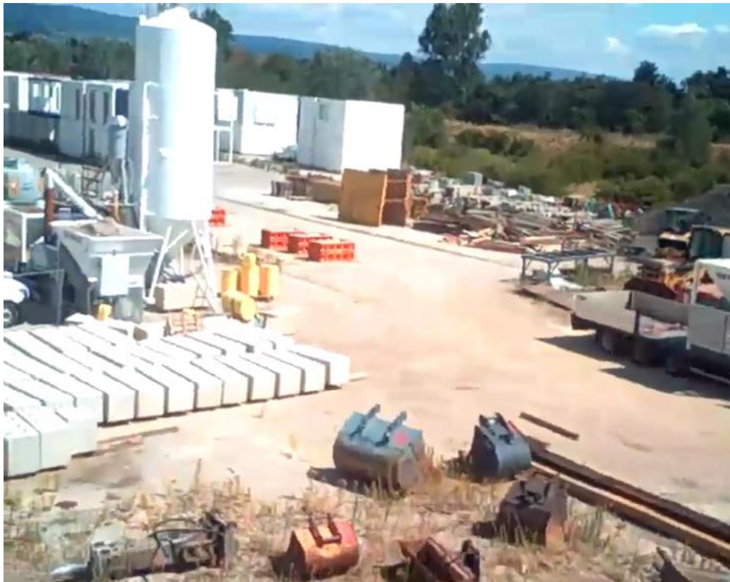
Bild 3: Lagerplatz für Bauzubehör
