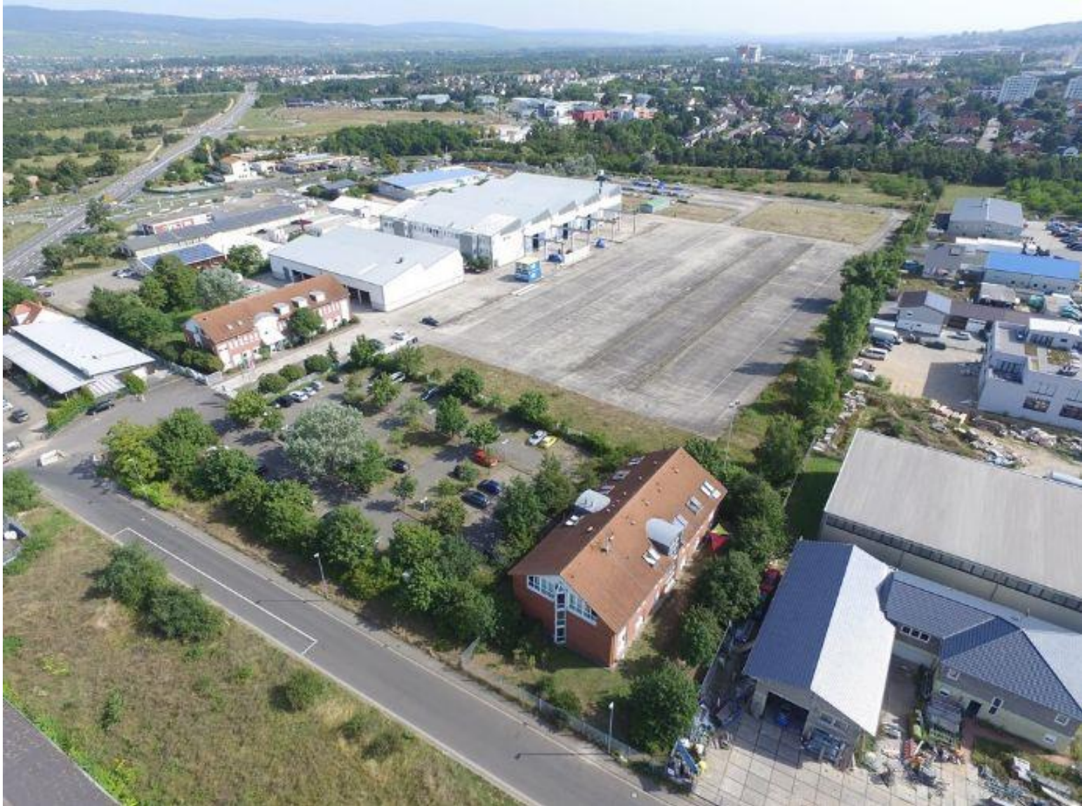
Bild 1: Übersicht Betriebsgelände Rheinstraße 40
