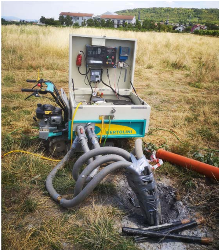
Foto 3: Durchführung des Geothermal Response Test an EWS 2 (Nord)
