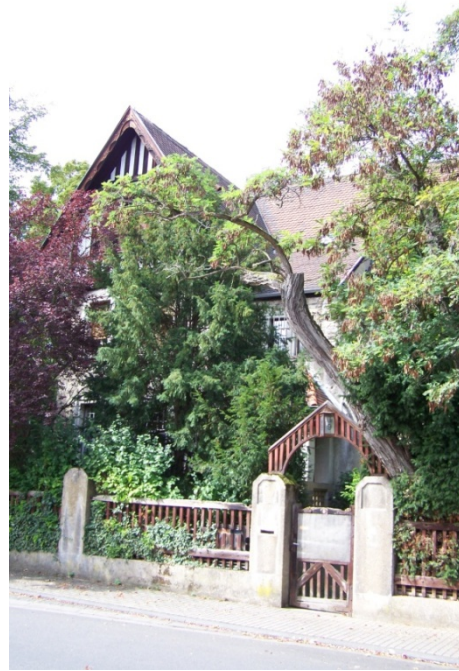
Eingangsbereich Villa Avenarius
