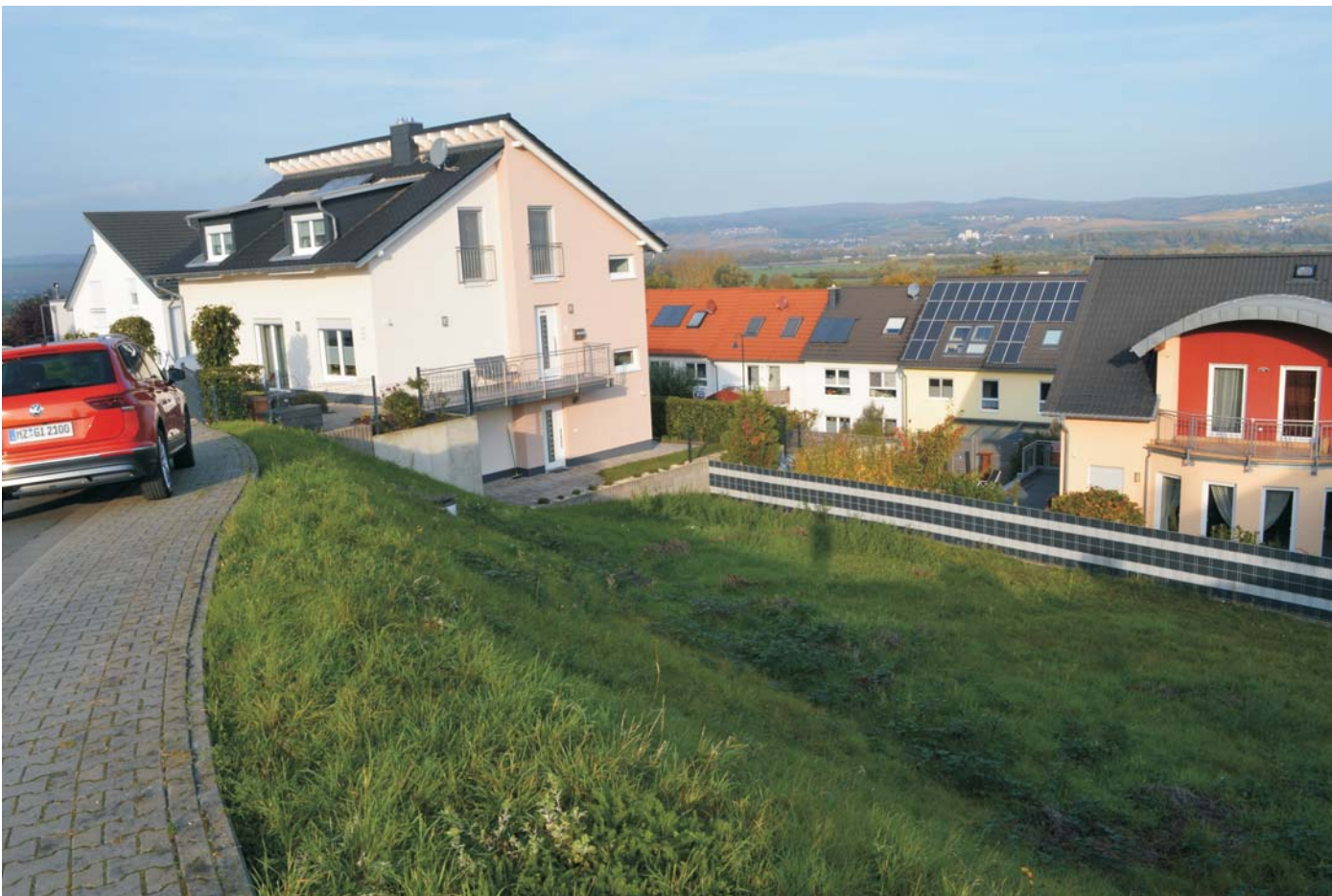
Bild 2: Böschung bei Schnitt S 2
