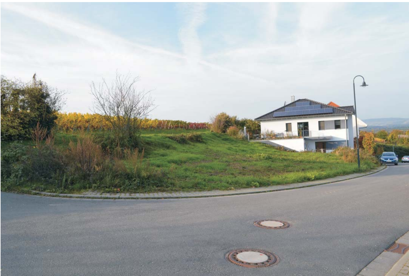
Bild 1: Böschung bei Schnitt S 1
