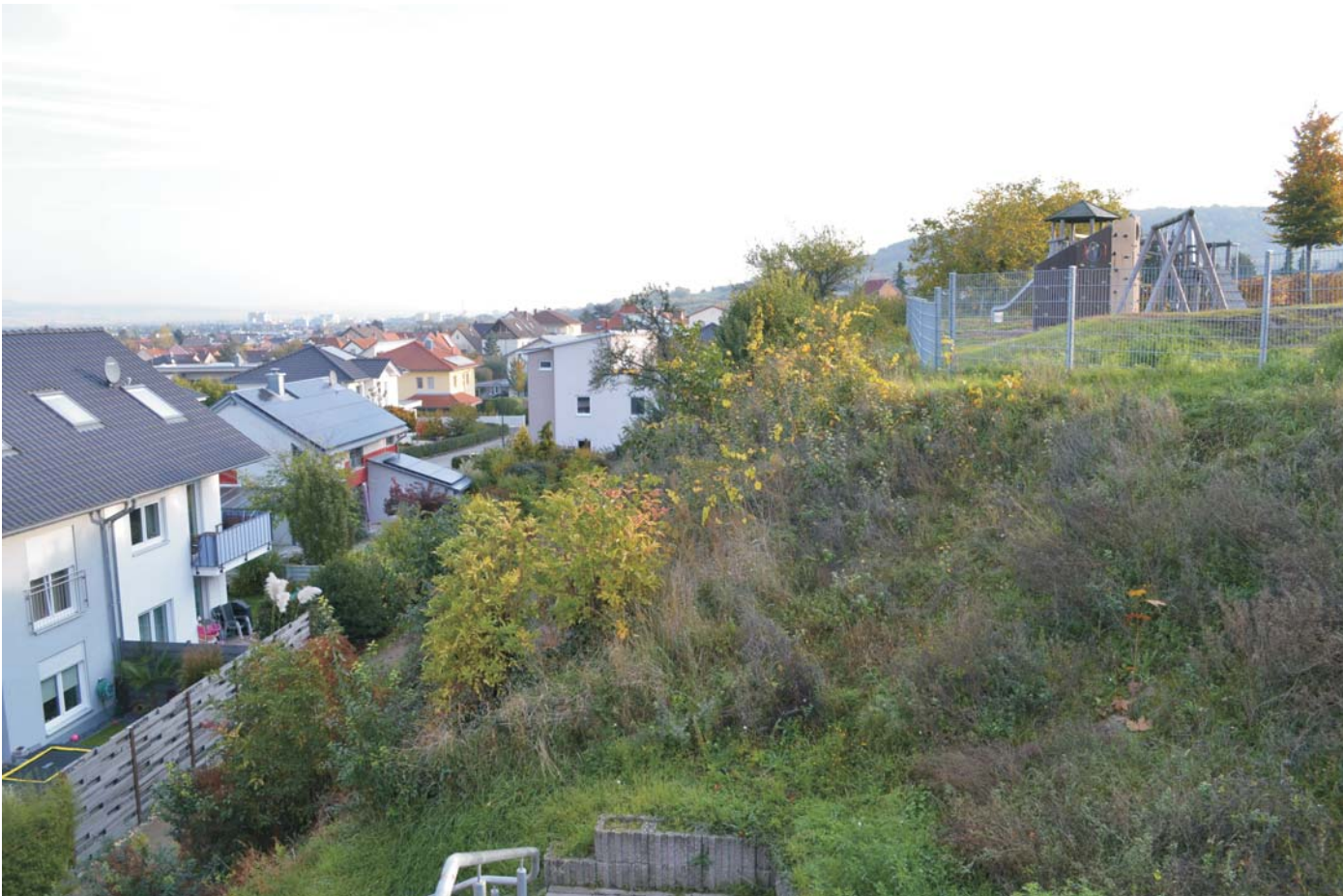
Bild 3: Böschung zwischen S 2 und S 3
