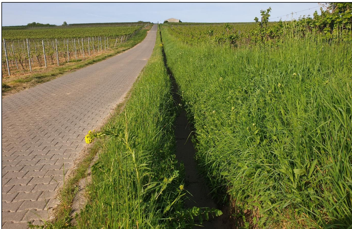
Abb. 21: Teilverbauter Graben im Norden
