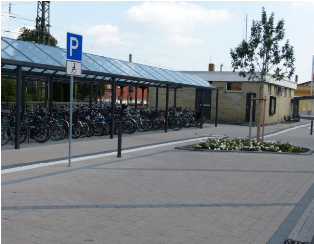
Das neue, barrierefreie Bahnhofsumfeld mit Blindenleitstreifen in Gau-Algesheim
