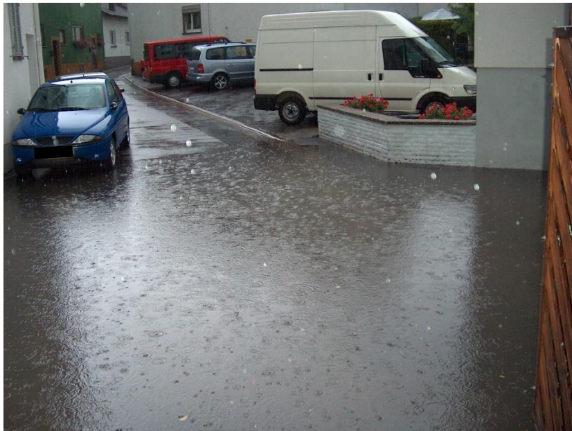
Abbildung 1: Rückstau des Regenwassers bei Starkregen (Bild eines Anwohners)
