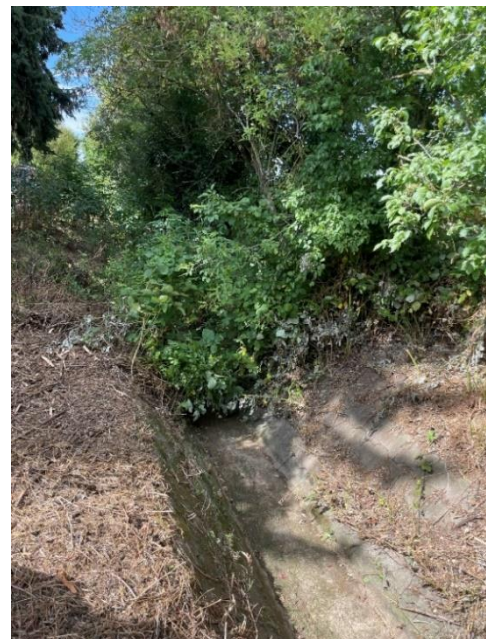
Abbildung 4: Bewuchs im Abflussprofil
