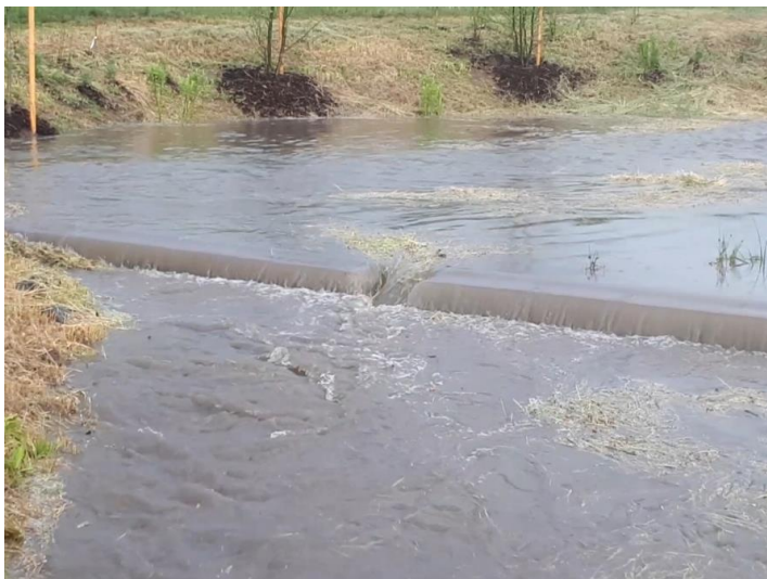
Abbildung 3: Gestaffeltes Retentionsbecken Taunusstraße (Bild eines Anwohners)
