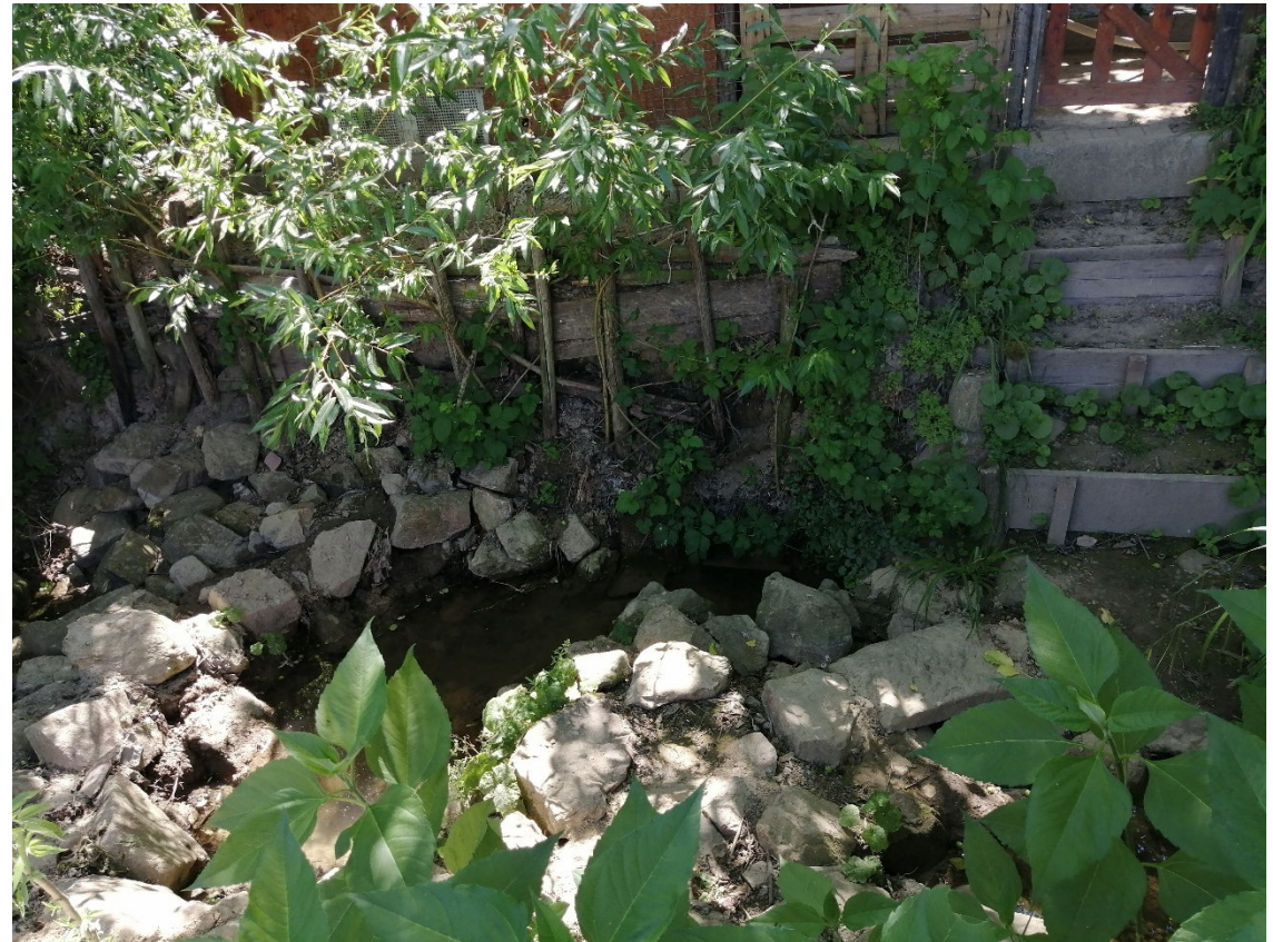
Abbildung 8: Steinquerung als Abflusshindernis am Engelstädter Graben
