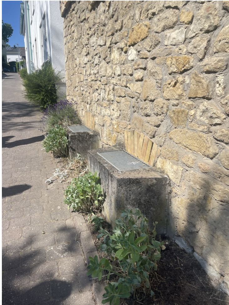
Abbildung 4: Positivbeispiel – hochwassersicherer Lichtschacht
