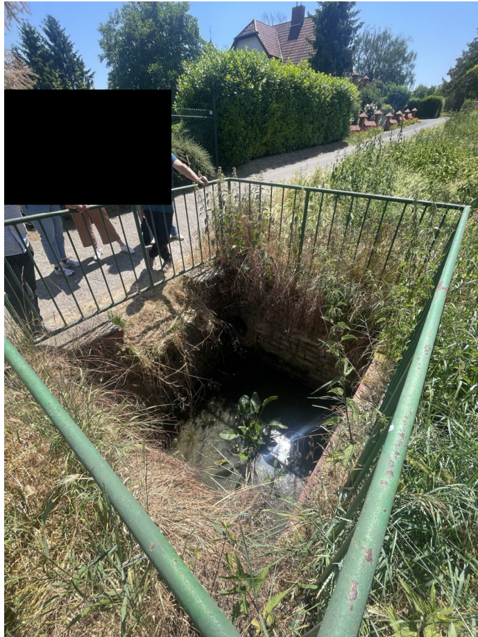
Abbildung 13: Auffangbecken mit Drosselablauf
