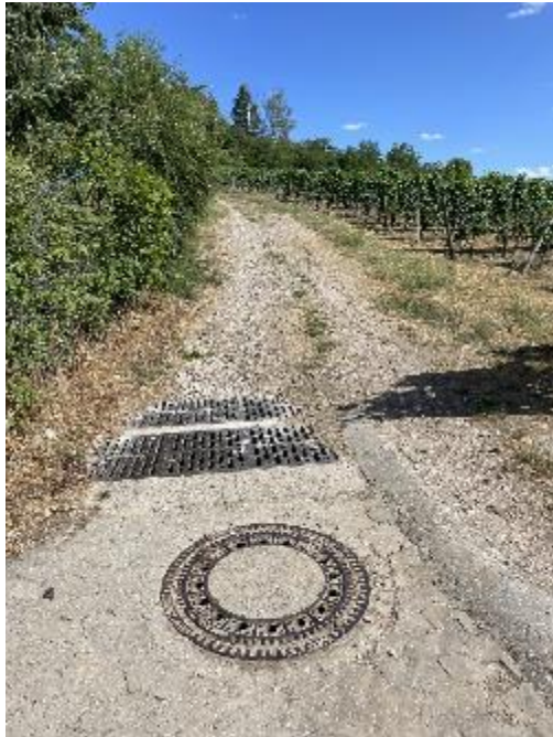
Abbildung 12: Außengebietsentwässerung in Höhe Hippel 33
