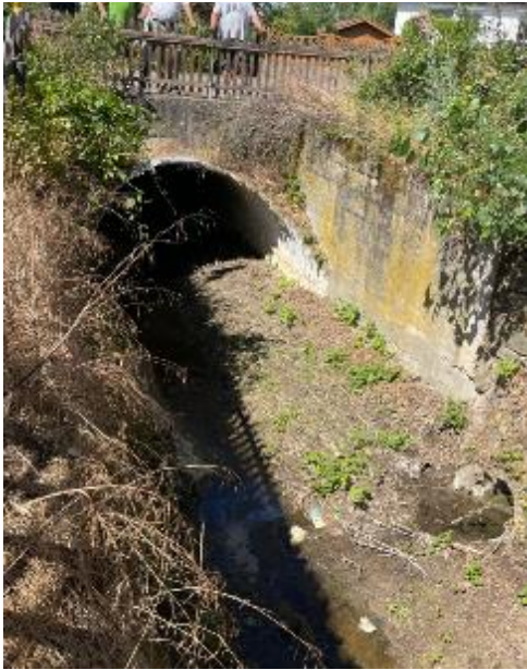
Abbildung 7: Durchlass an der Straße An der Layenmühle
