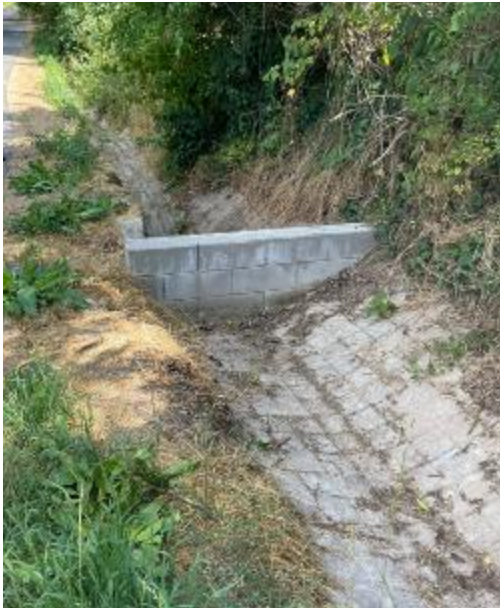
Abbildung 3: Mauer im Graben "Am Breiten Weg"
