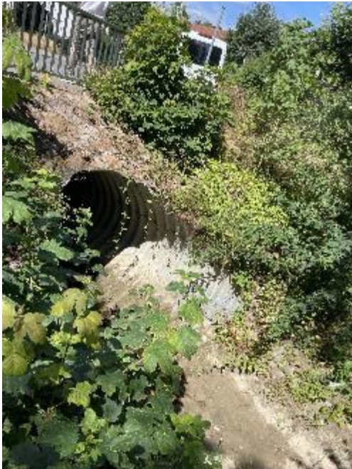
Abbildung 4: Durchlass am Welzbach unter der Straße "Im Hippel"
