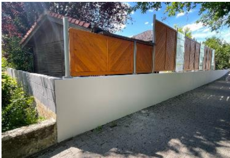
Abbildung 9: Privat errichtete Mauer eines Anwohners zum Schutz vor Hochwasser
