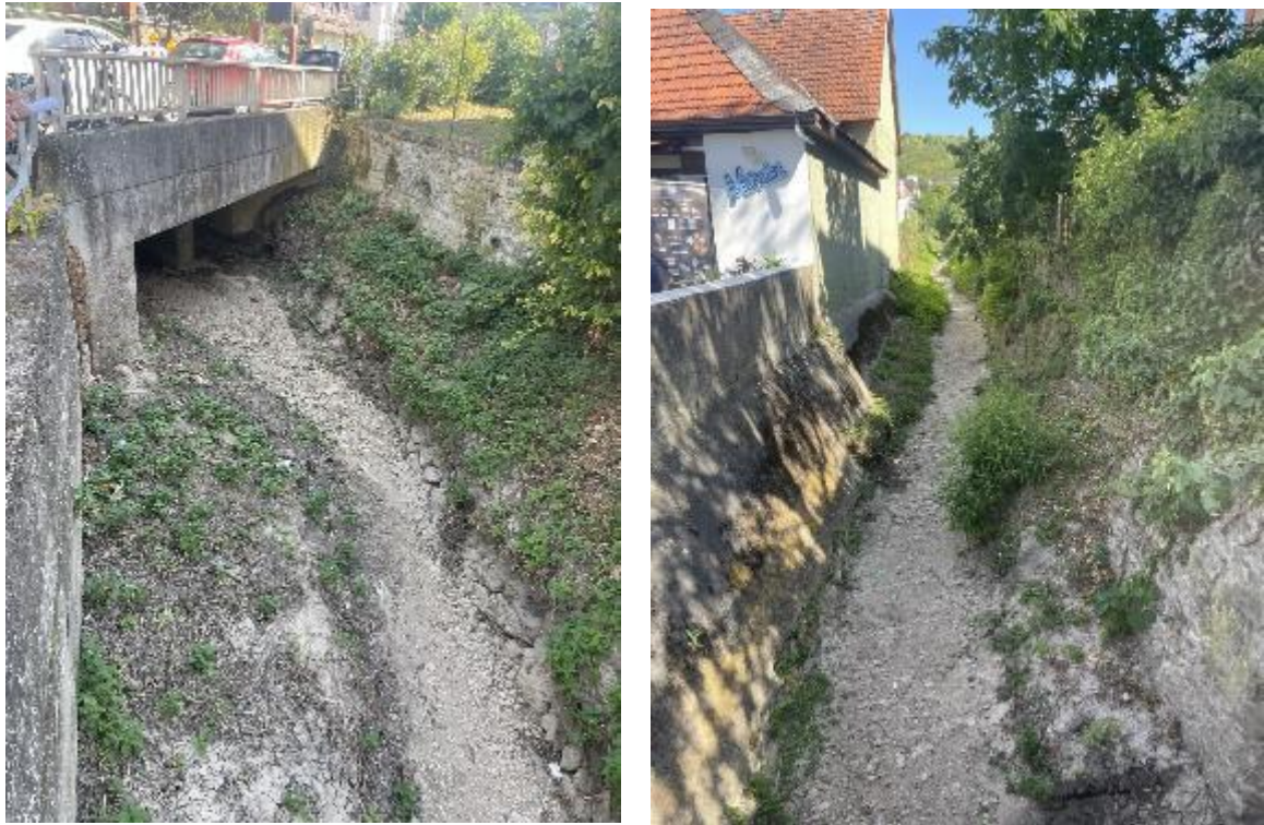
Abbildung 15: Ablagerungen im Bereich der Bahnhofstraße. Sowohl südlich (rechts) als auch nördlich (links) des Durchlasses.
