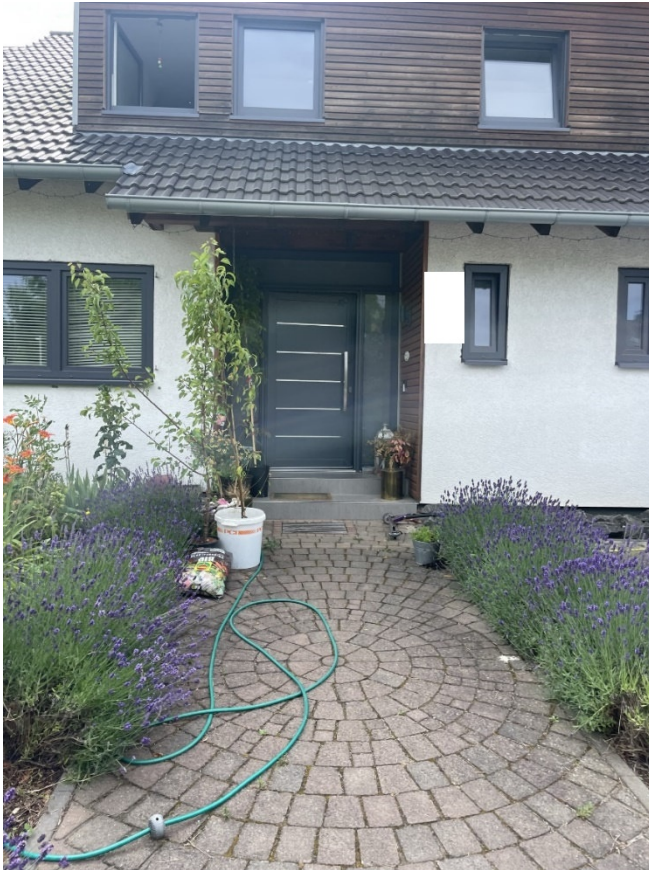
Abbildung 4: Hochwasserangepasstes Bauen „In den Frohngärten“
