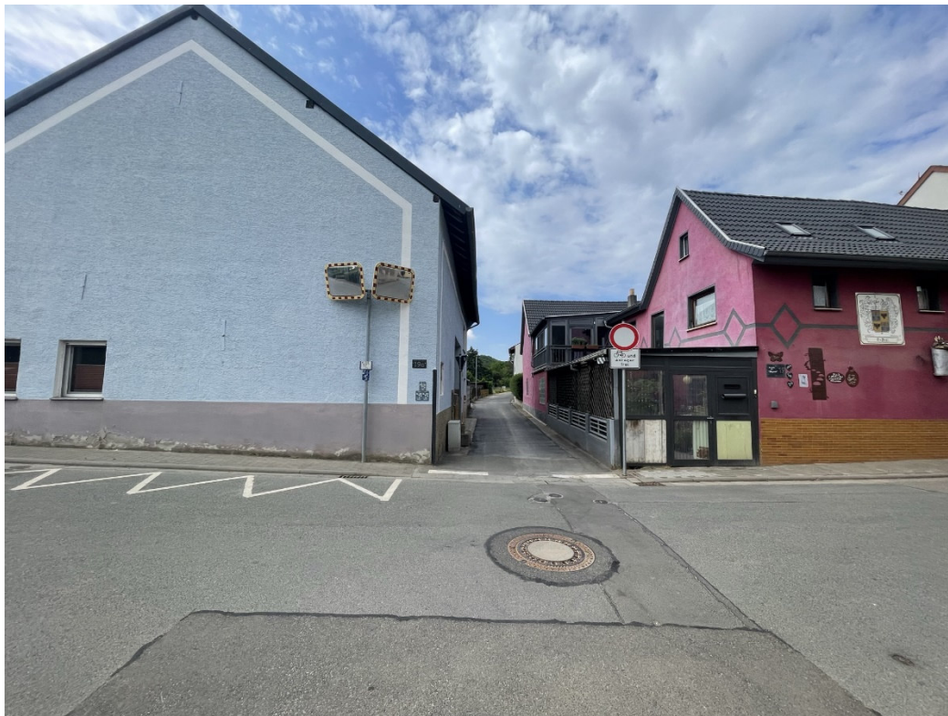
Abbildung 6: Tiefpunkt/Hochwassersammlung im Überschwemmungsgebiet (In den Frohngärten/Am Schlag)
