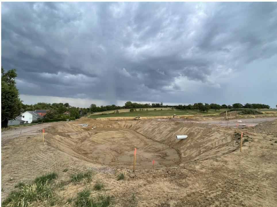
Abbildung 8: Regenrückhaltebecken im Neubaugebiet
