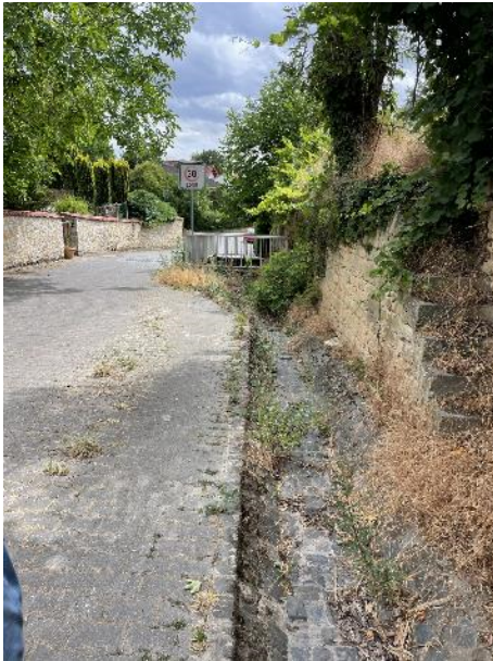
Abbildung 12: Zufuss zum Einlaufbauwerk in Mainzer Straße
