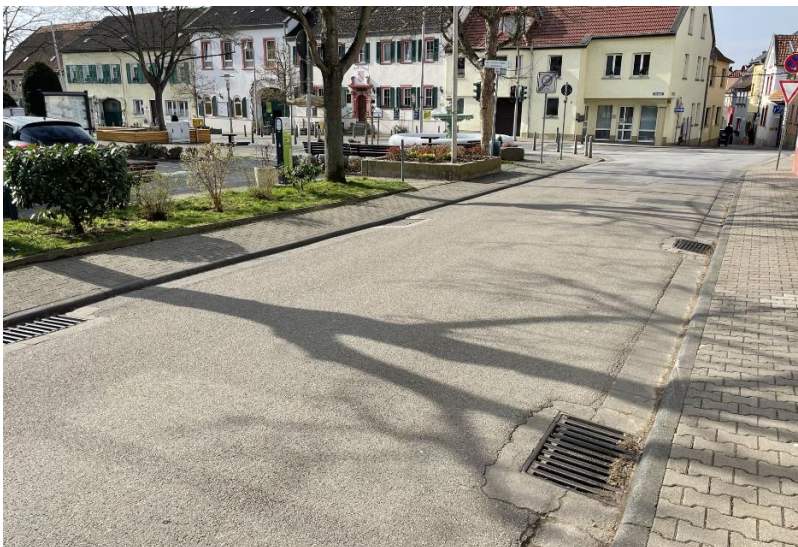
Abbildung 13: Straßeneinläufe in der Nähe des Marktplatzes
