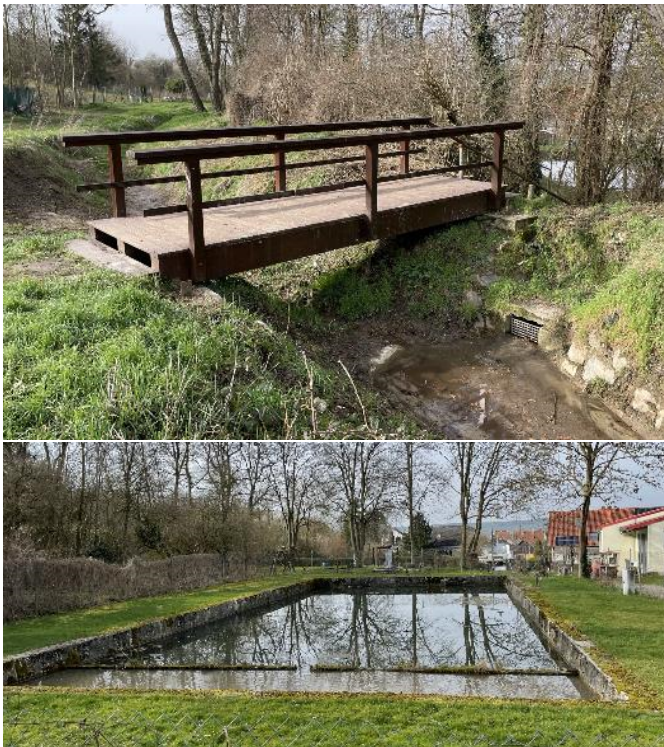
Abbildung 8: Überleitung zum Brandweiher/ehem. Schwimmbad
