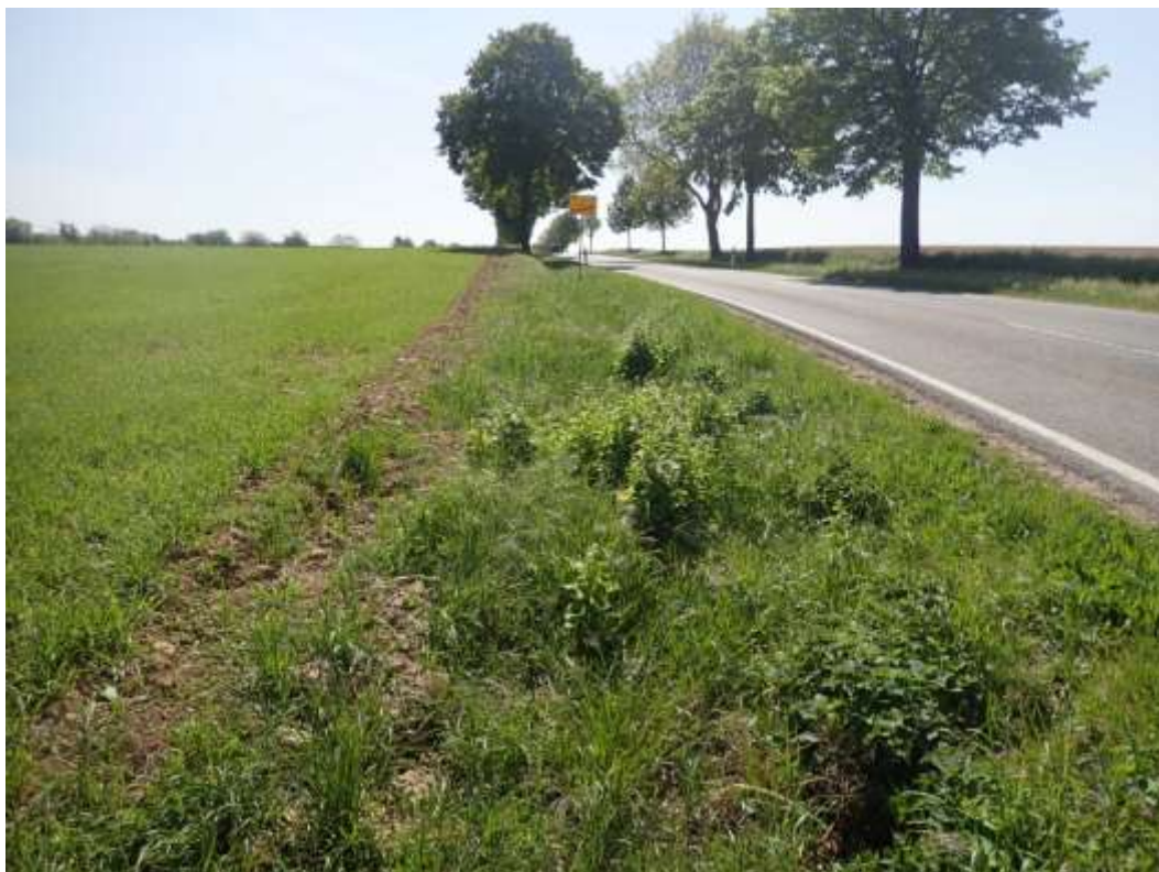
Bild 08: Der trockene Graben entlang der Landesstraße mit ausdauernder Ruderalvegetation, insbesondere im nördlichen Teil
