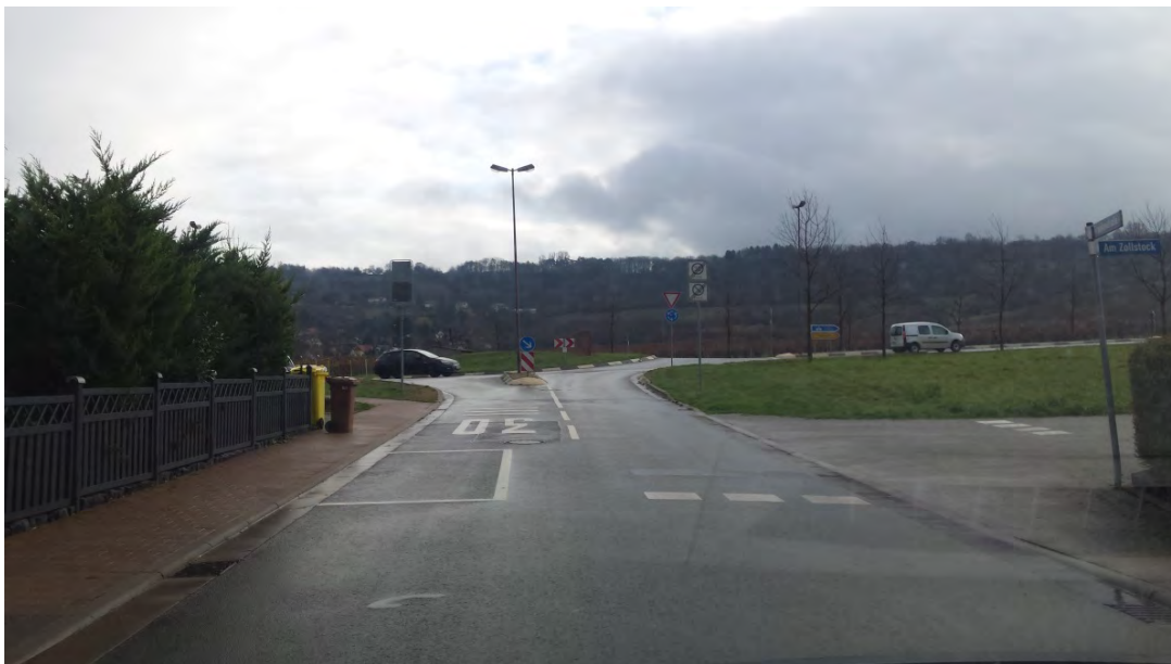
Abbildung 2.1: Fotodokumentation – Blick aus der Frankenstraße auf den künftigen Anschluss
