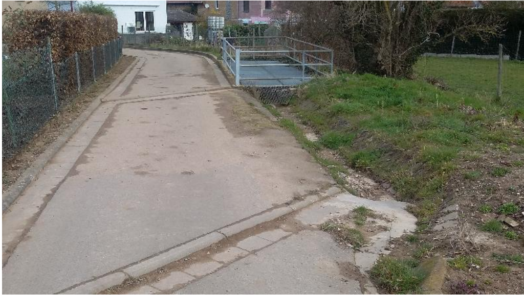
Foto: Best. Einlaufbauwerk (SF4) Michelstraße
