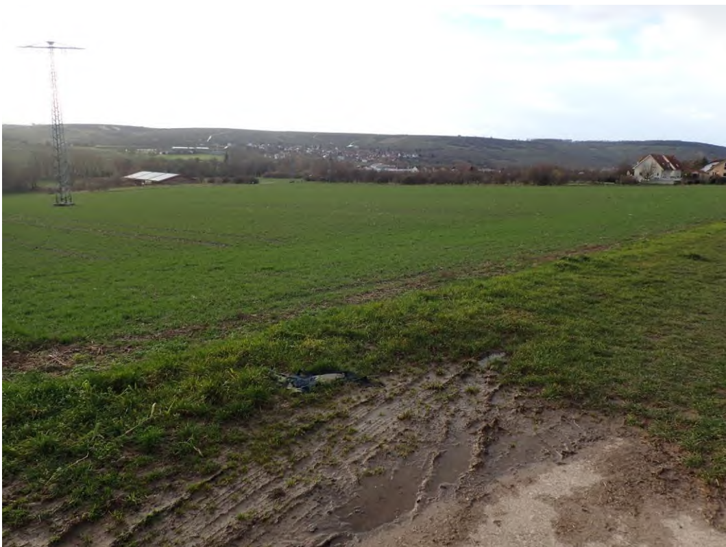
Bild 02: Blick auf den Bereich, in dem die geplante Ortsumgehung entstehen soll
